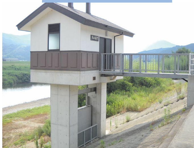
肱川多田樋門(国土交通省大洲河川国道事務所)
