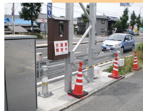
簡易トラフィックカウンターによる自動交通計測
