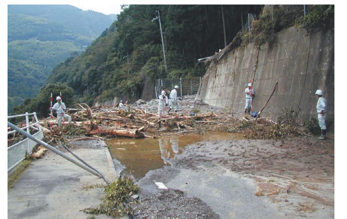
（国）194号災害測量（愛媛県西条地方局建設部）
