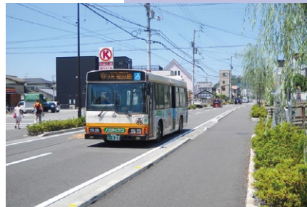
六軒家石手線(愛媛県中予建設部)
