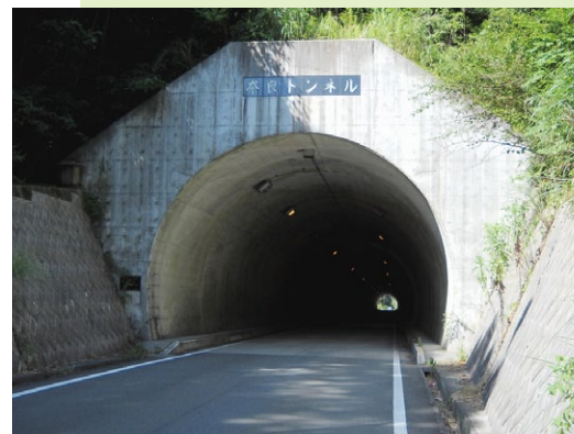
奈良トンネル（愛媛県宇和島土地改良課）
