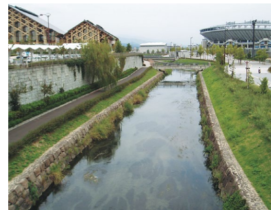
傍示川改修(松山市)
