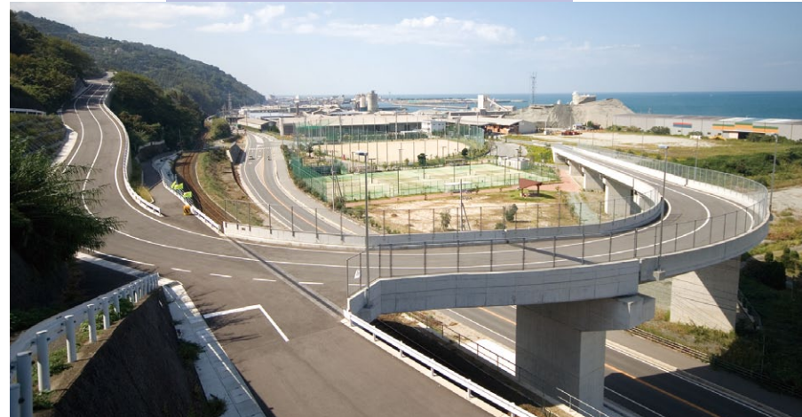
黒田大屋線高架橋(愛媛県大洲土木事務所)
