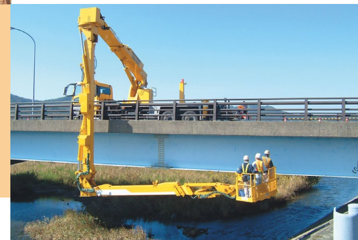
橋梁点検車によるメンテナンス調査
