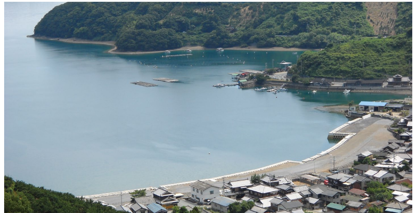
俵津漁港護岸（愛媛県西予土木事務所）
